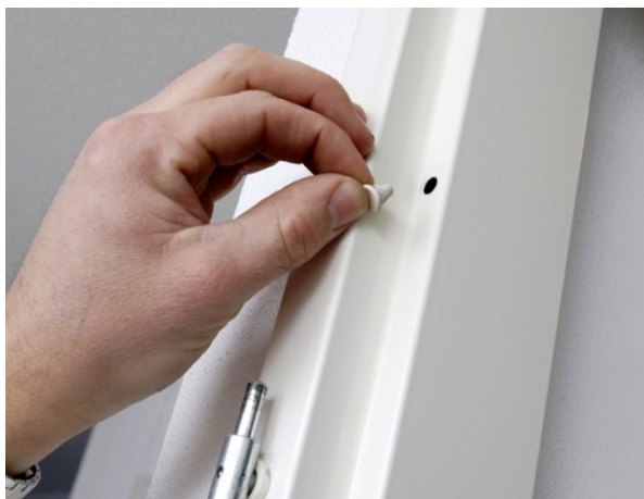
Stalen kozijn (wordt) voorzien van afdekdopje
